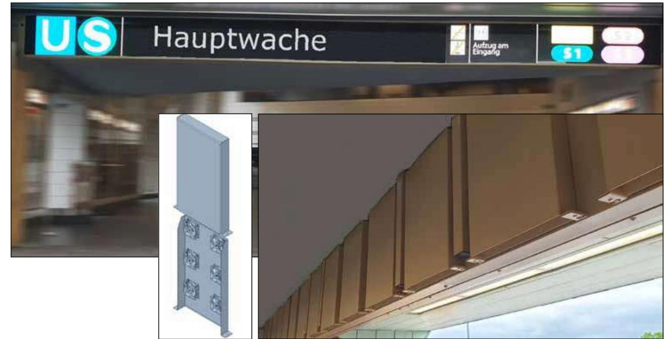
Lüftungskassetten zum einfachen Revisionieren und austauschen des aktiven Belüftungssystems.
